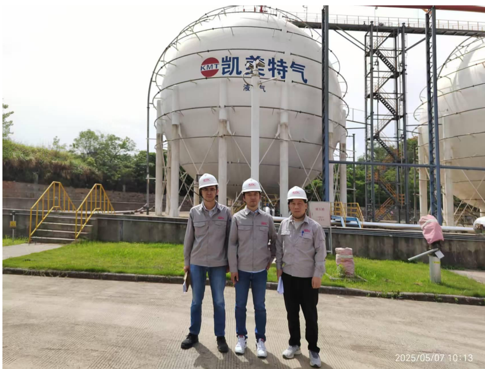
凯美特公司液化气、戊烷储罐区
