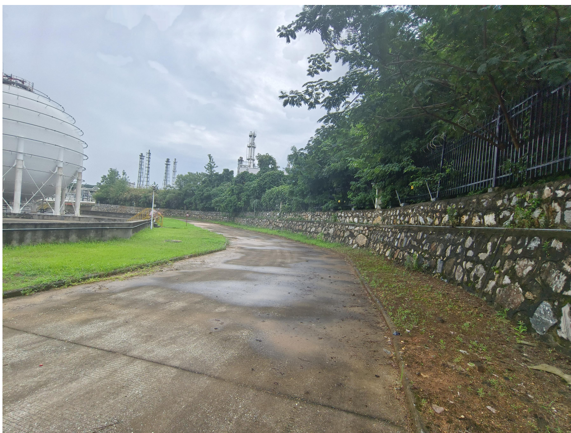
凯美特公司罐区厂外南侧
