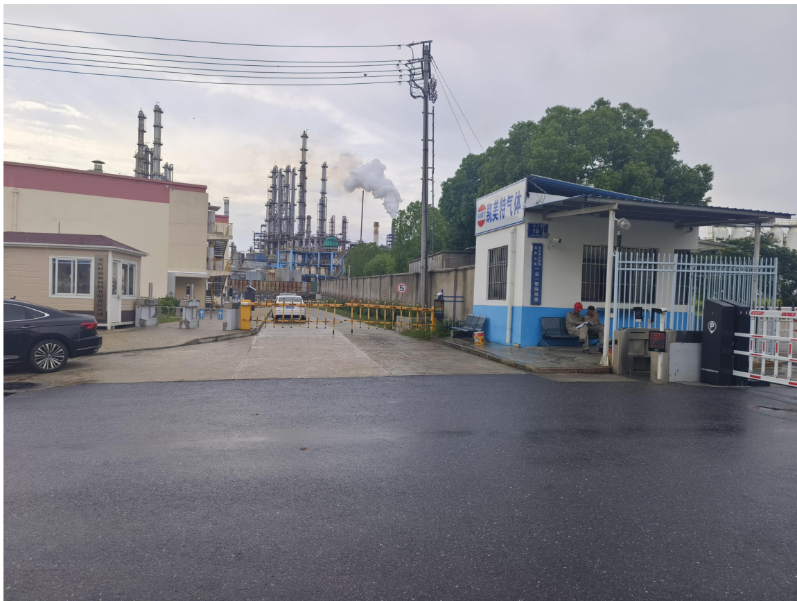
凯美特公司炼厂尾气、火炬气分离及提纯装置厂外西侧
