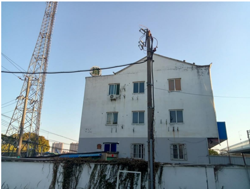
图 2-8 加油站南侧为 3 层民用建筑、通讯塔和架空电力线路
