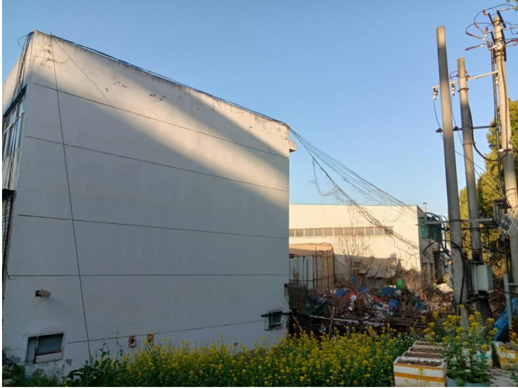
图 7 项目北侧 2 层民用建筑和架空电力线路
