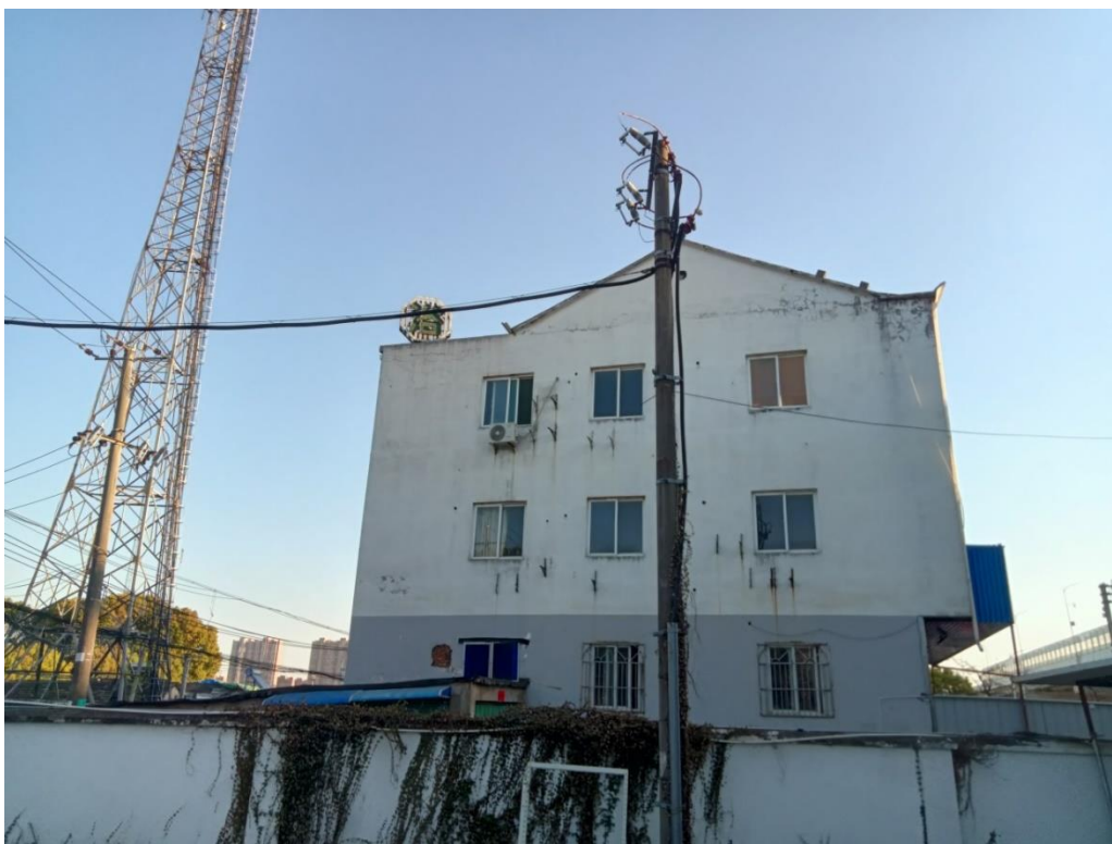
图 5 项目南侧 3 层民用建筑、通讯塔和架空电力线路
