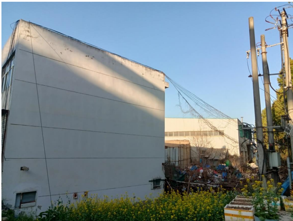
图 2-10 加油站北侧为 2 层民用建筑和架空电力线路
