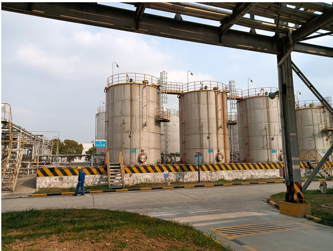
本项目东侧依托的装置罐区
