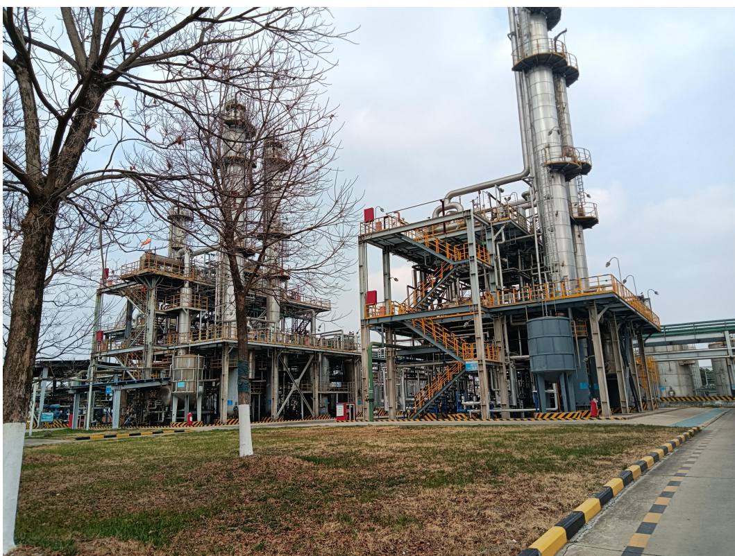
本项目南侧 902 装置
