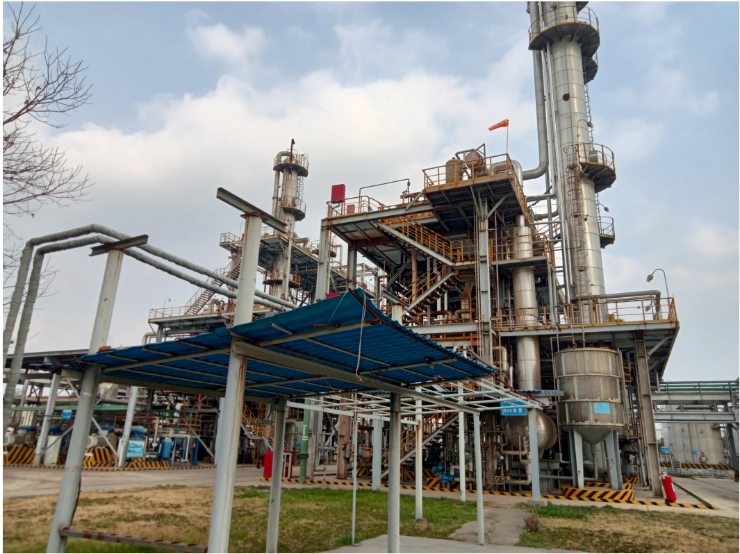
本项目技改项目 906 装置
