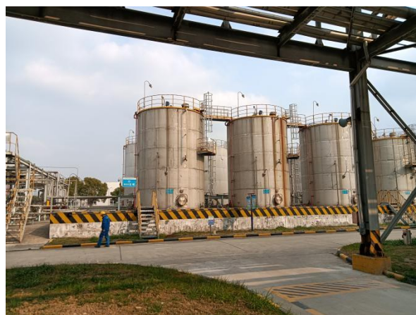
东侧装置罐区
