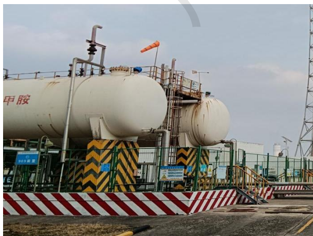
东侧一甲胺罐区（停产）
