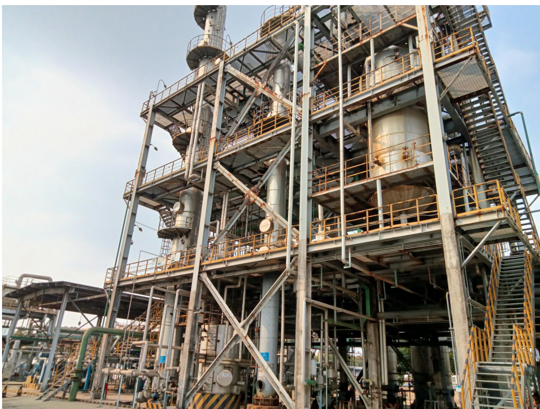
本项目北侧 901 装置
