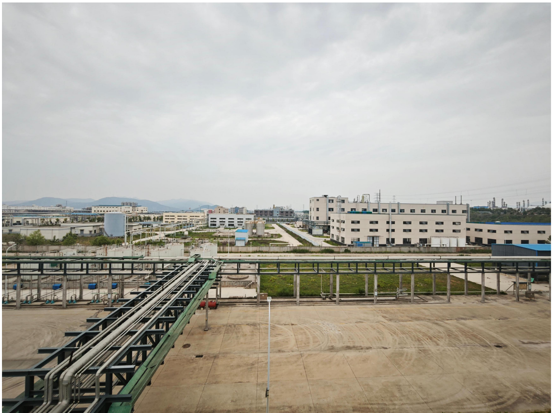
厂区北侧：安徽春华材料科技有限公司、安庆市月铜铝业
