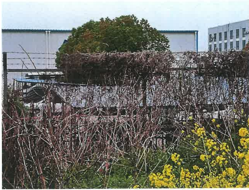
图 6 项目北侧为安徽中电兴发与鑫龙科技股份有限公司停车棚和一台室外变压器
