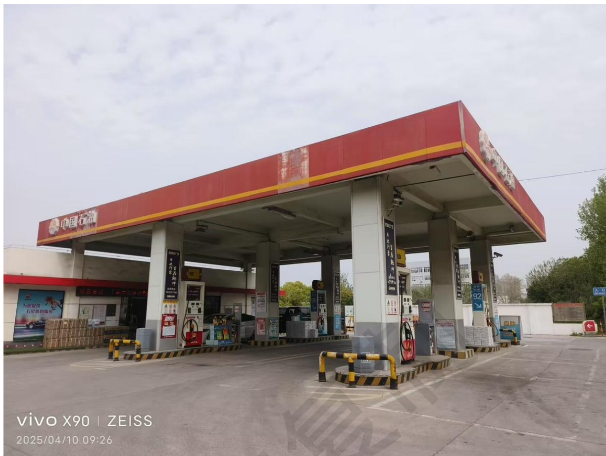
图2-9 加油站全景照片
