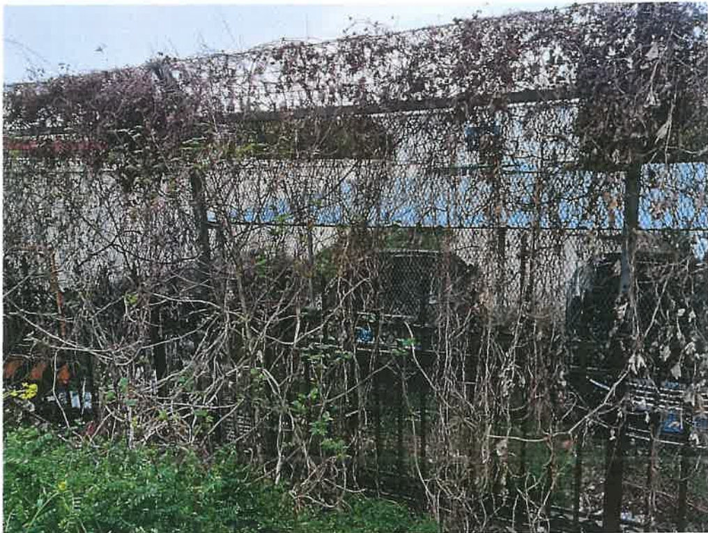
图 4 项目西侧安徽中电兴发与鑫龙科技股份有限公司停车棚
