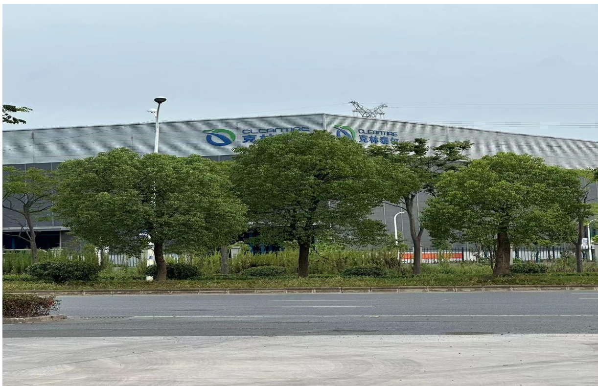
图 2-3 南侧勇进路，路南安徽省克林泰尔再生资源科技有限公司
