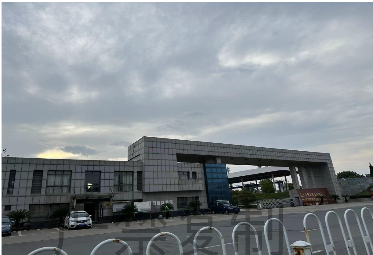
图 2-4 西侧环城西路，路西安庆市泰发能源科技有限公司
