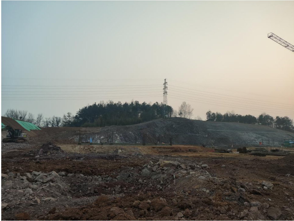
图 5 项目建南侧架空电力线路
