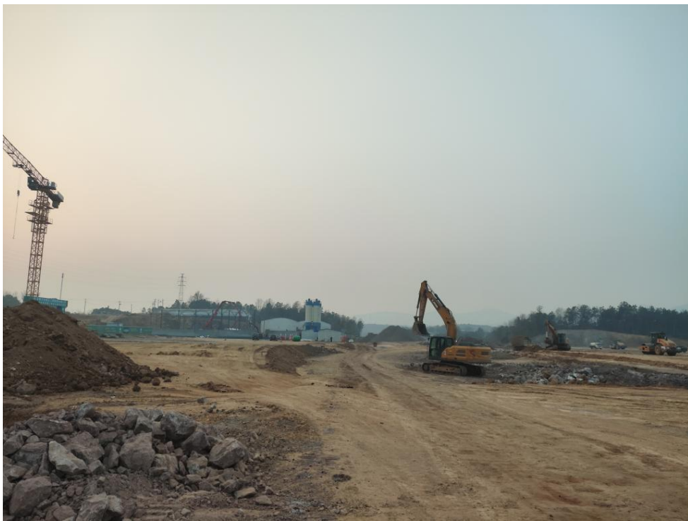
图 6 项目建西侧服务区综合楼以及停车场（在建）
