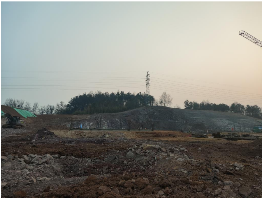
图 1.3 项目建南侧架空电力线路
