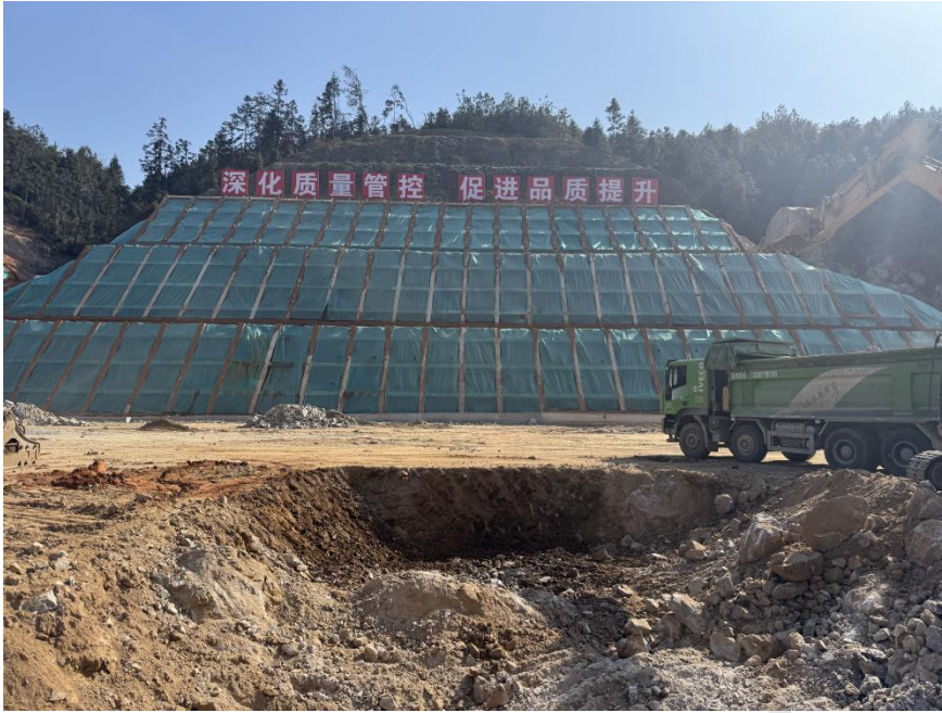
图 1.5 项目北侧垃圾房（在建）、雨水回收及综合楼（在建）
