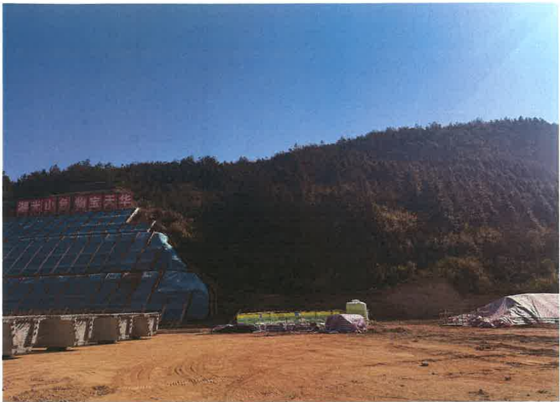
图4 项目东侧停车场（在建）和综合楼（在建）
