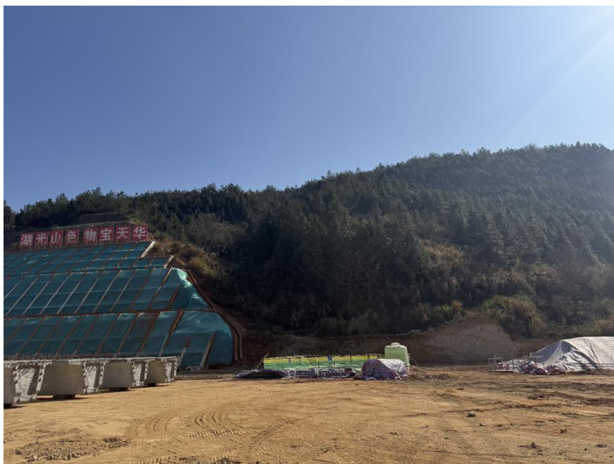
图 1.3 项目东侧服务区停车位（在建）
