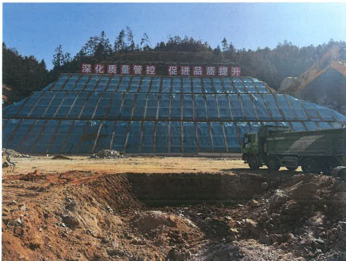
图3 项目北侧垃圾房（在建）
