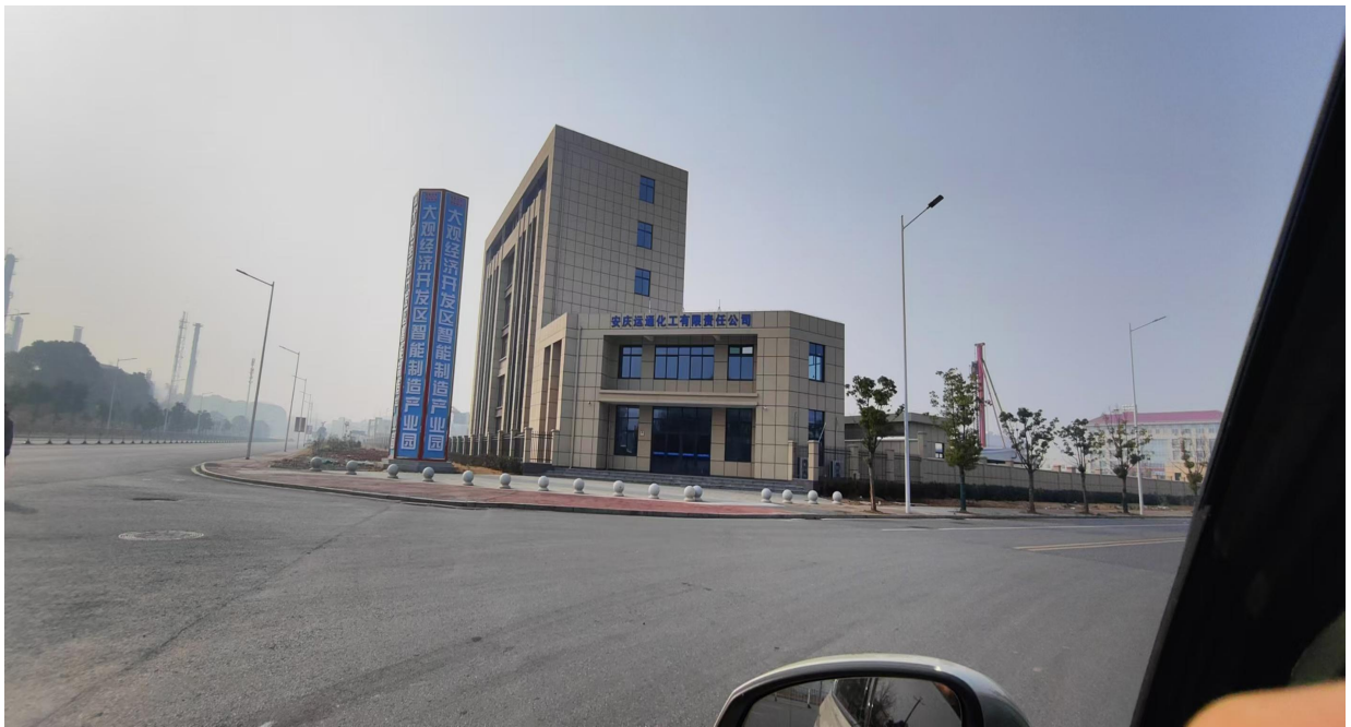
照片七 园区北侧安庆运通化工有限责任公司
