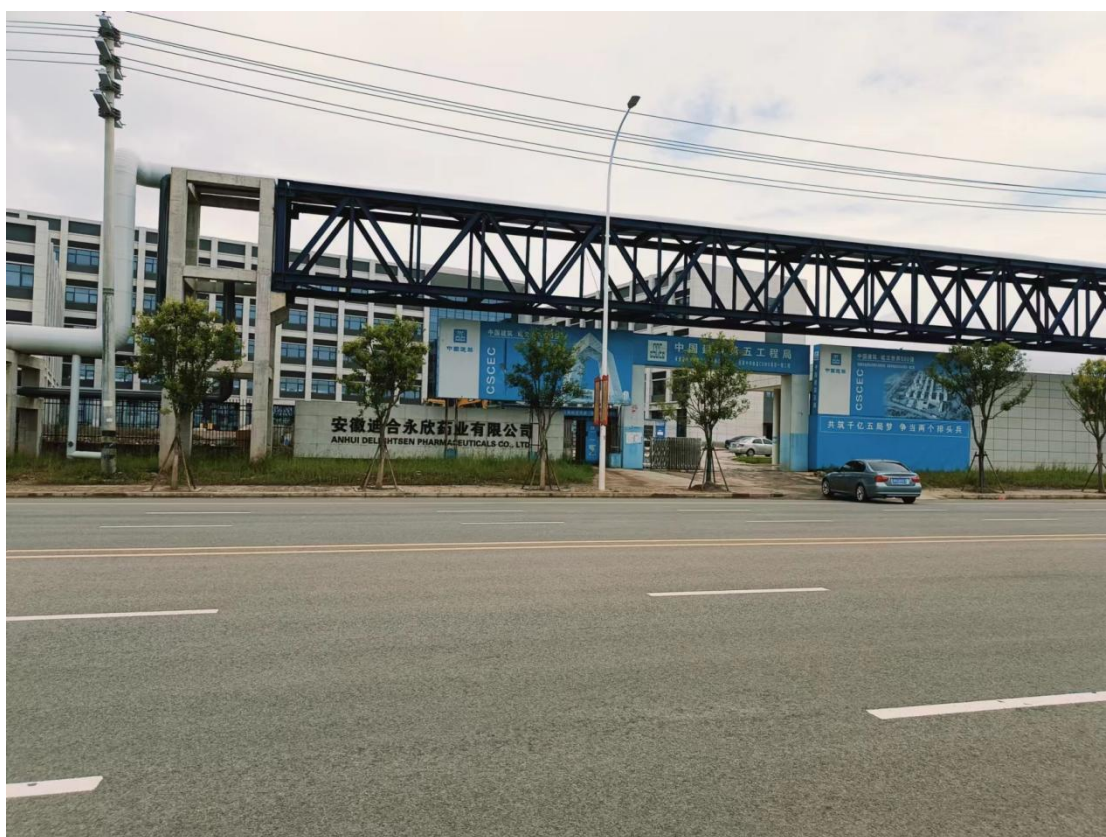
厂区南侧-迪合永欣药业
