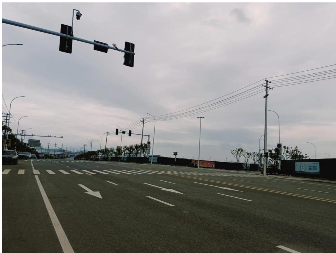
厂区东侧-石门湖路
