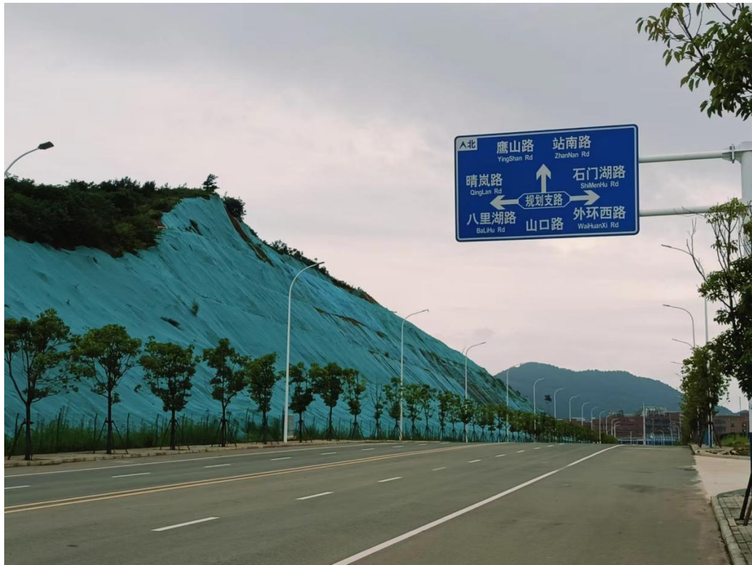
厂区西侧-山体
