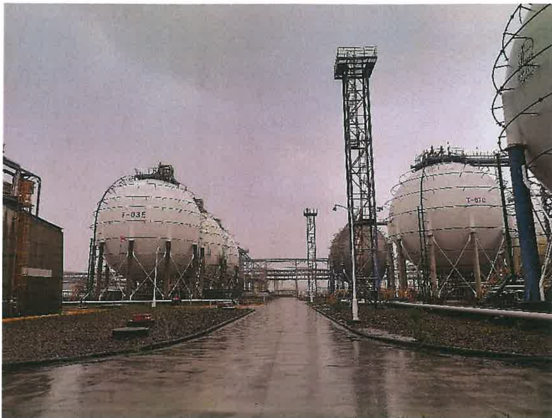
镇海炼化分公司生产厂区现场勘查照片（2024.6.29）
