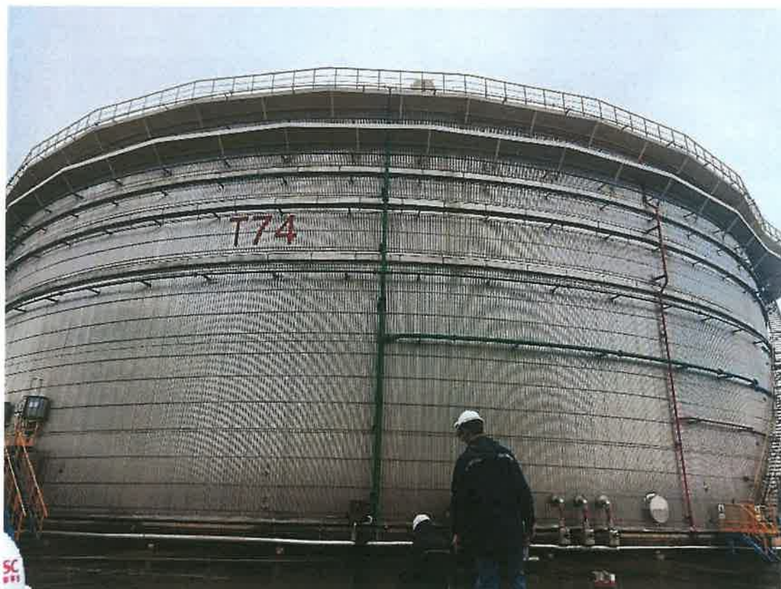
港务储运部现场勘查照片（2024.6.27）
