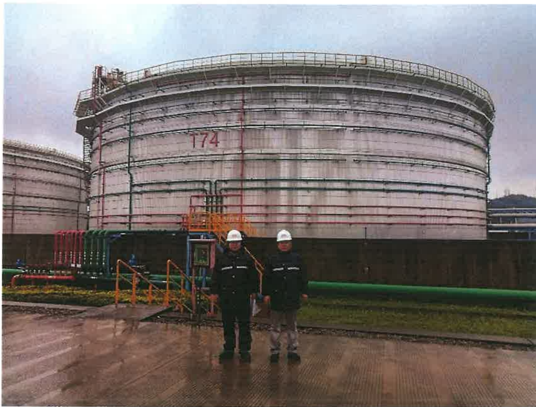
港务储运部现场勘查照片（2024.6.27）
