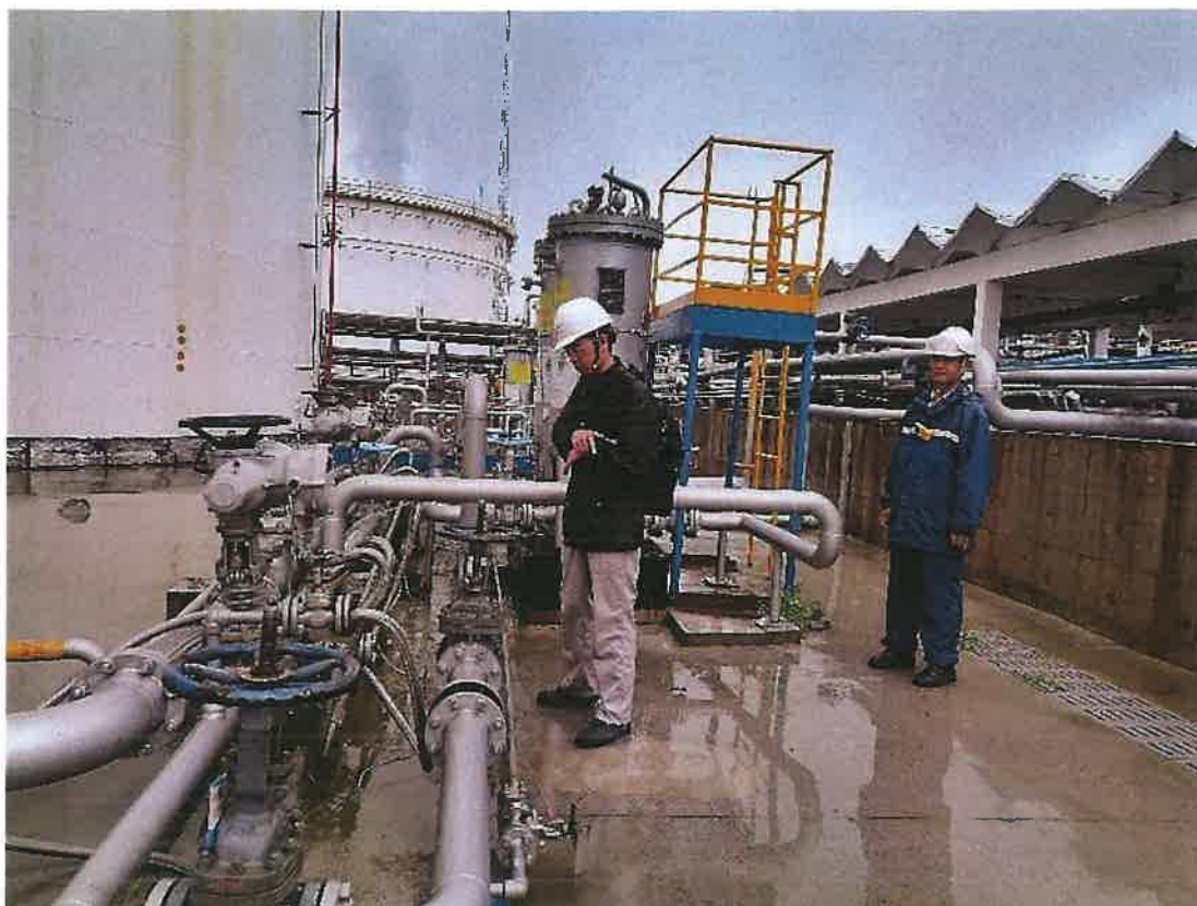
镇海炼化分公司生产厂区现场勘查照片（2024.6.30）
