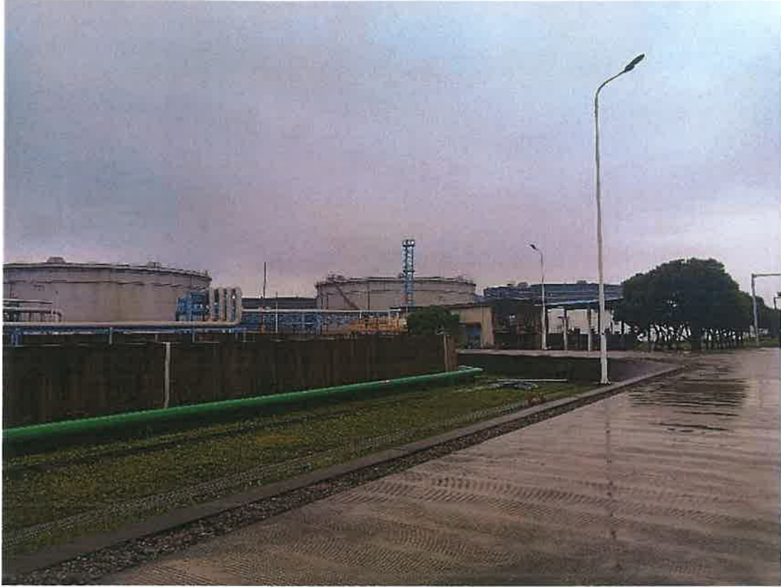
港务储运部现场勘查照片（2024.6.28）
