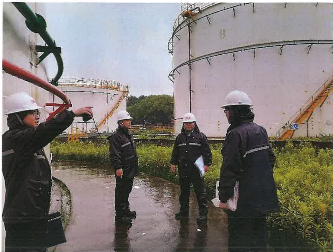
成品油码头现场勘查照片（2024.6.28）
