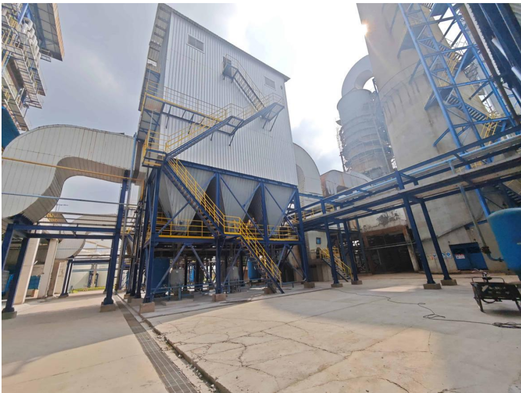
(2) 北侧锅炉脱硝除尘设施
