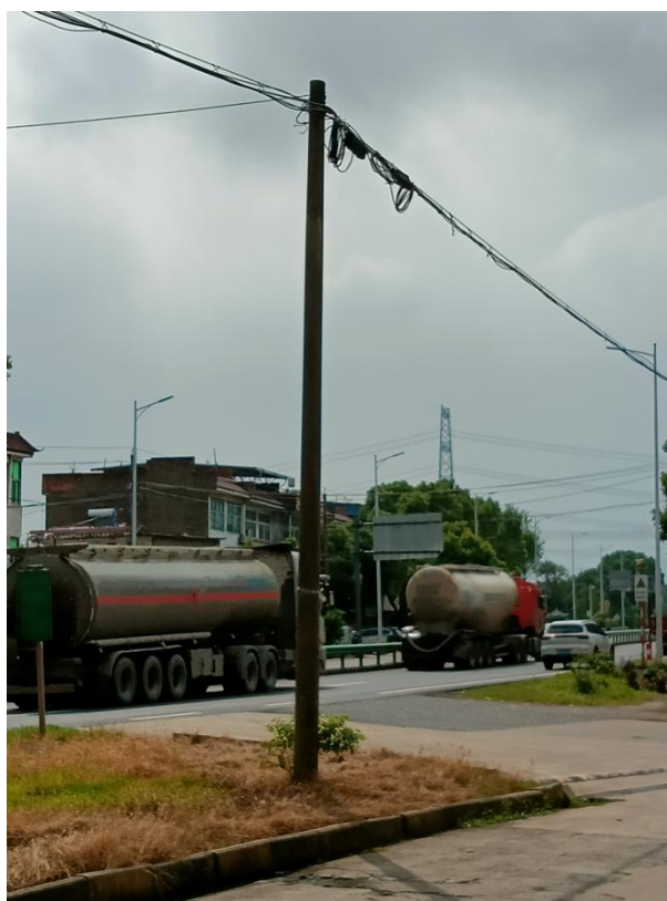
图1 建东侧有一架空通信线、芜铜路，芜铜路建东侧为有经营商铺的三层民用建筑群
