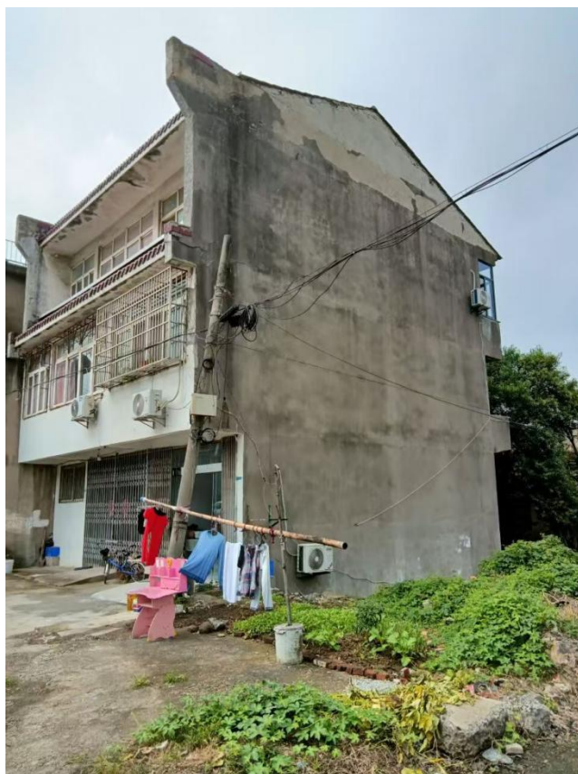
图2 建南侧为民宅群
