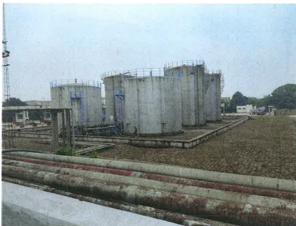
图 5 项目南侧庆达石化发油站柴油储罐区（101A/101B 停用，待拆除）
