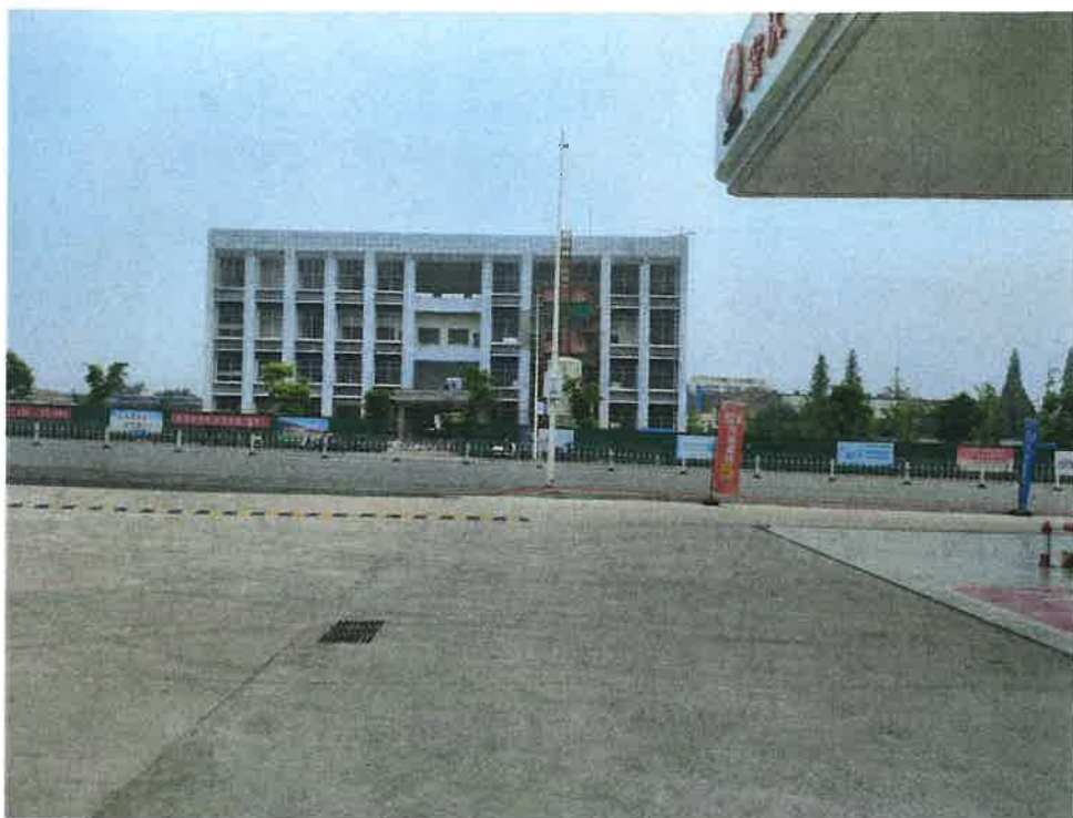
图 7 项目北侧腓北路，腓北路的北侧为安庆市环卫基地，目前处于在建状态
