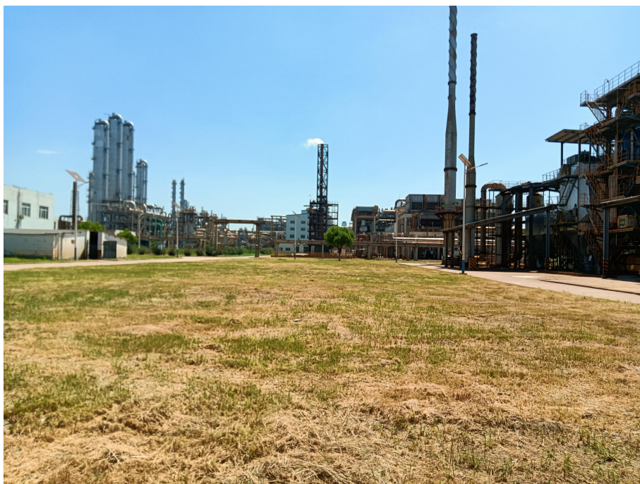
东侧初期雨水池和冷冻站
