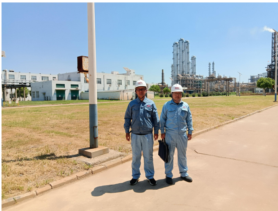
新增废气处理设施预留空地
