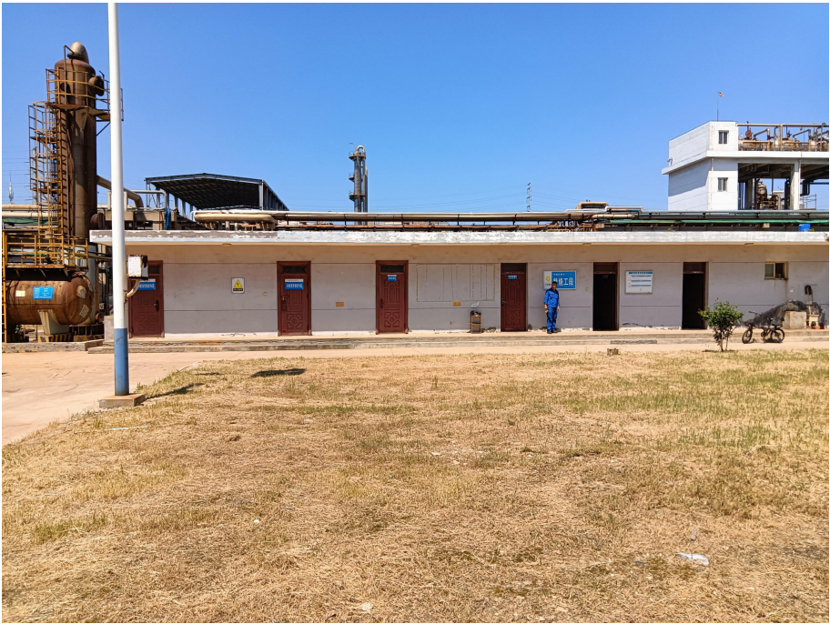
西侧焚烧变电室
