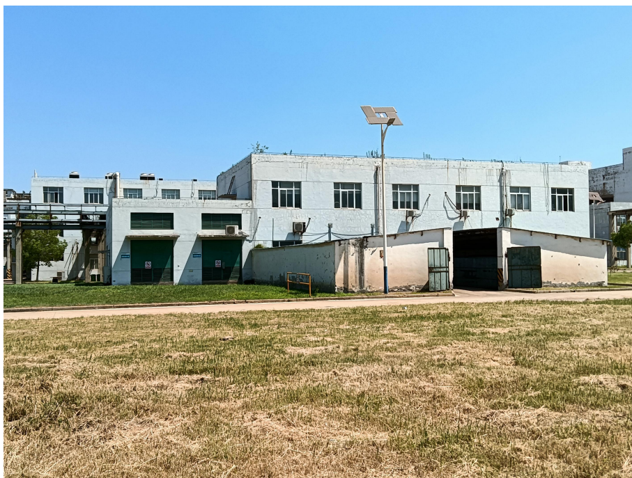
北侧维修车间（含变电所）
