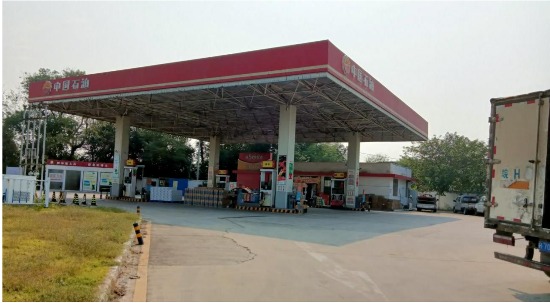
新城加油站全景照片
