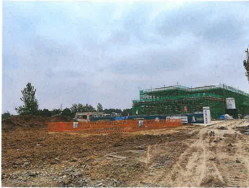
图 3 项目东侧服务区综合楼、停车场（在建）
