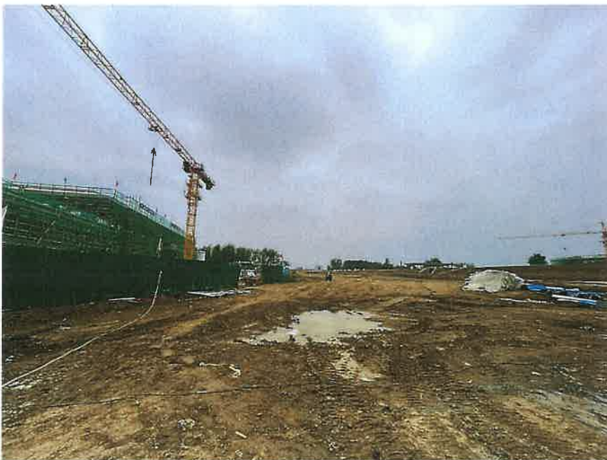
图 4 项目西侧服务区综合楼、服务区停车场(在建)
