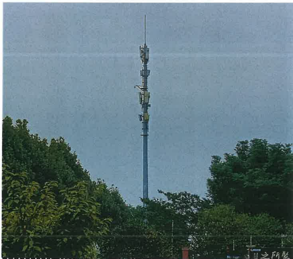
图 6 项目南侧通信发射塔
