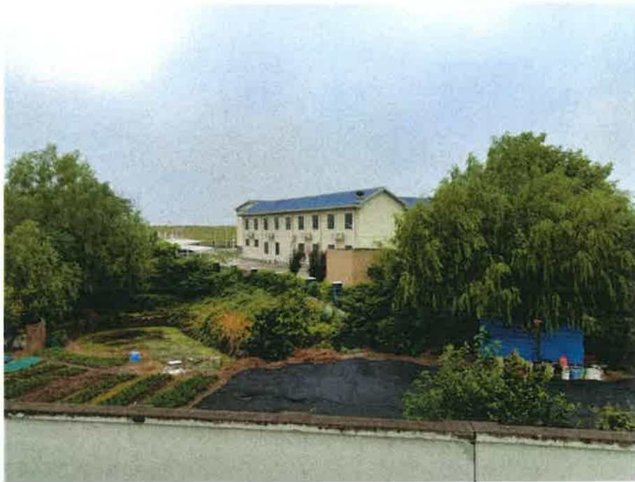
图 7 项目西侧鲁港水利管理站用房
