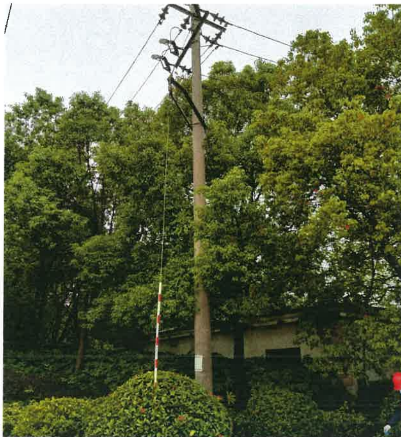
图 5 项目南侧废弃民房和架空电力线路
