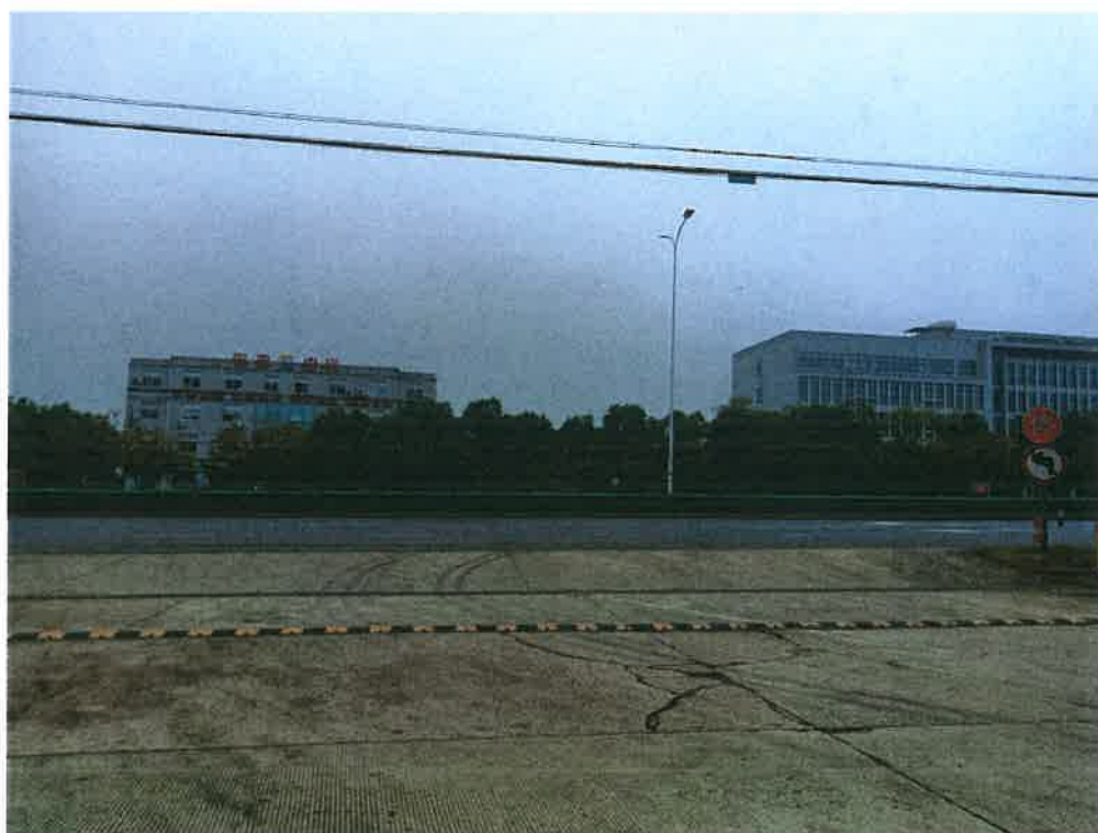
图 4 项目东侧芜屯路、架空通信线路
