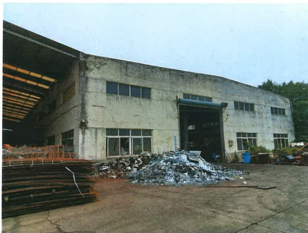
图 6 项目西侧芜湖远方再生资源有限公司
