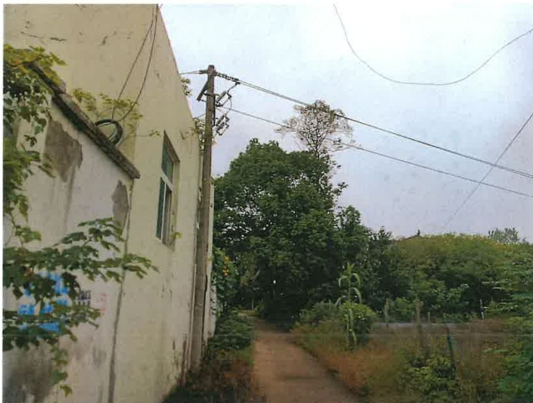
图 6 项目西南侧架空电力线路
