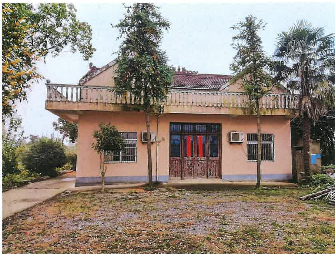
图 7 项目西南侧民房（三类保护物）
