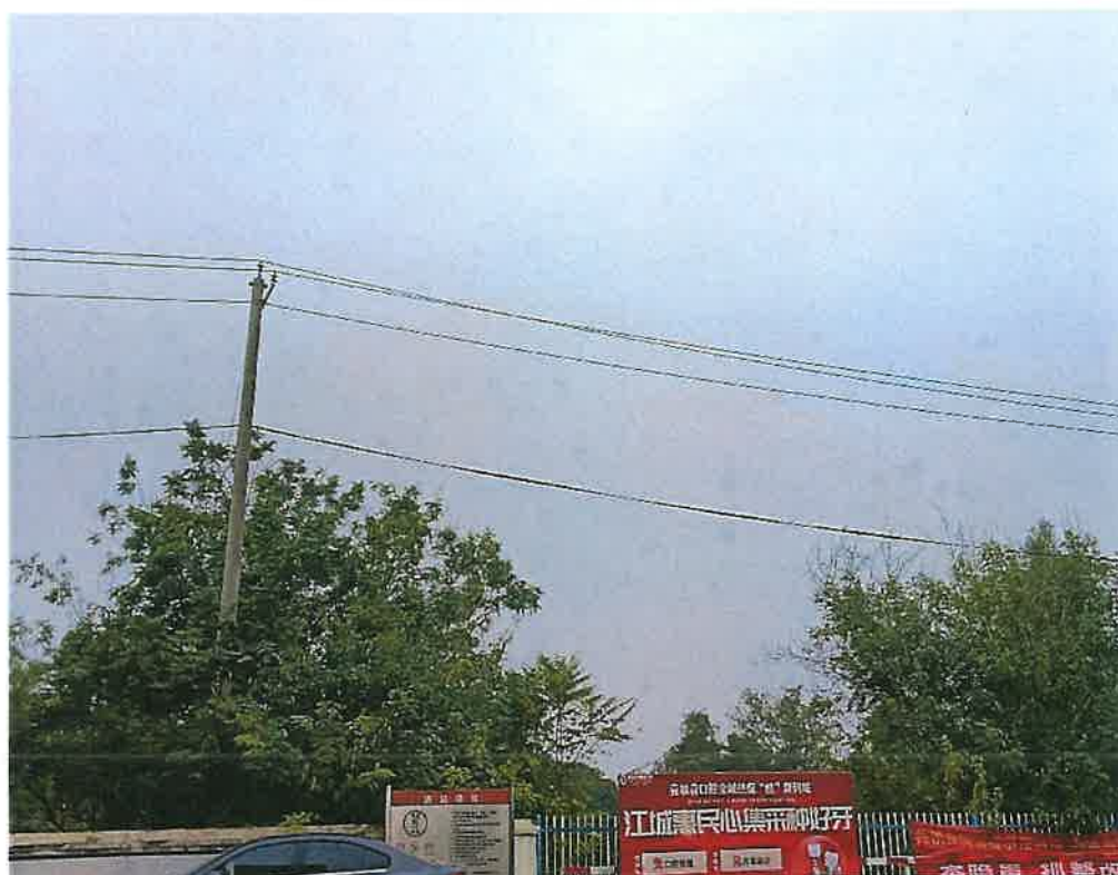
图 4 项目西侧架空电力线
