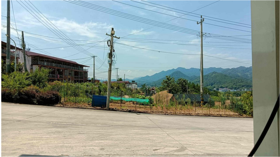
项目南侧X092公路及电力线
