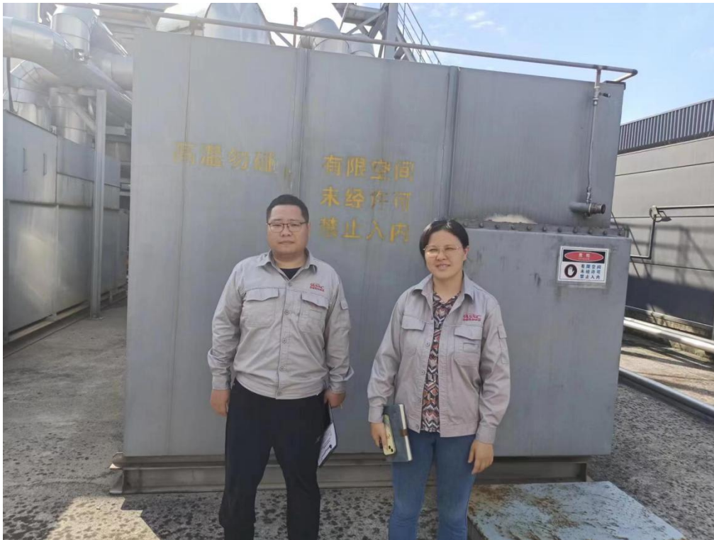
评价人员现场勘察照片
