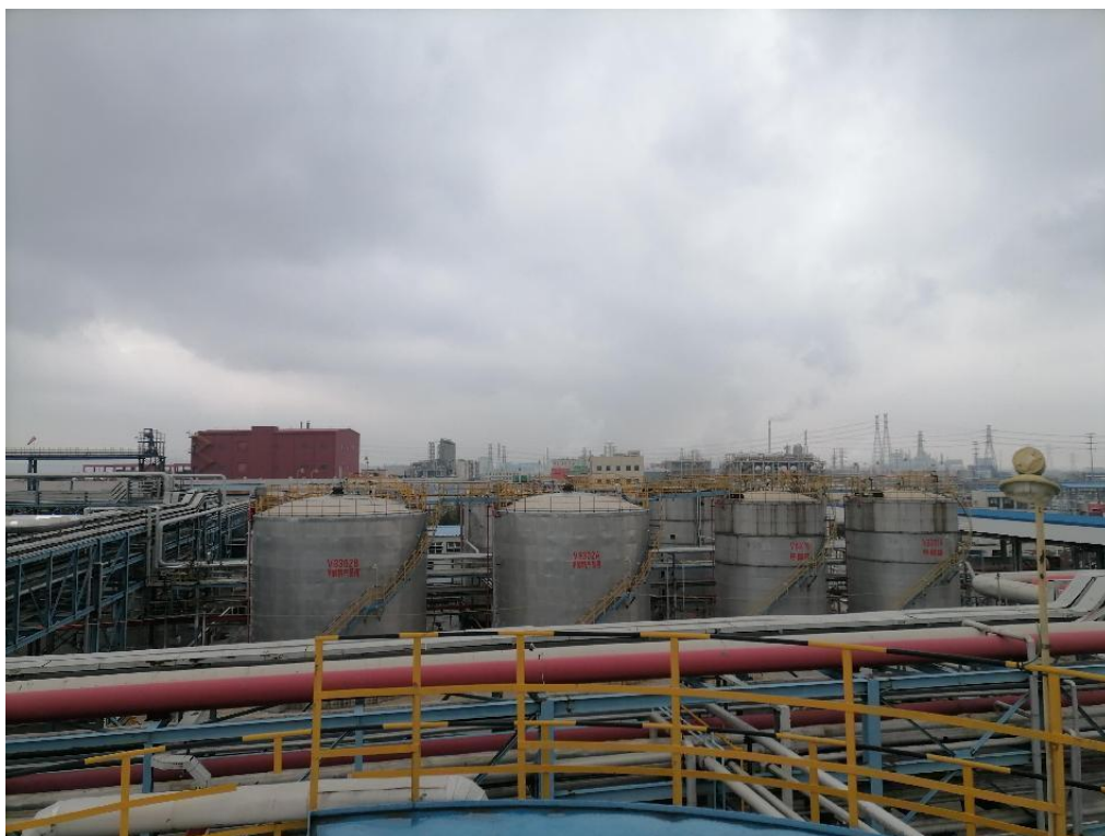
原料及产品罐区 1
