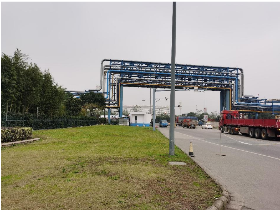
厂区西面化工区管廊和镇海国家石油储备基地
