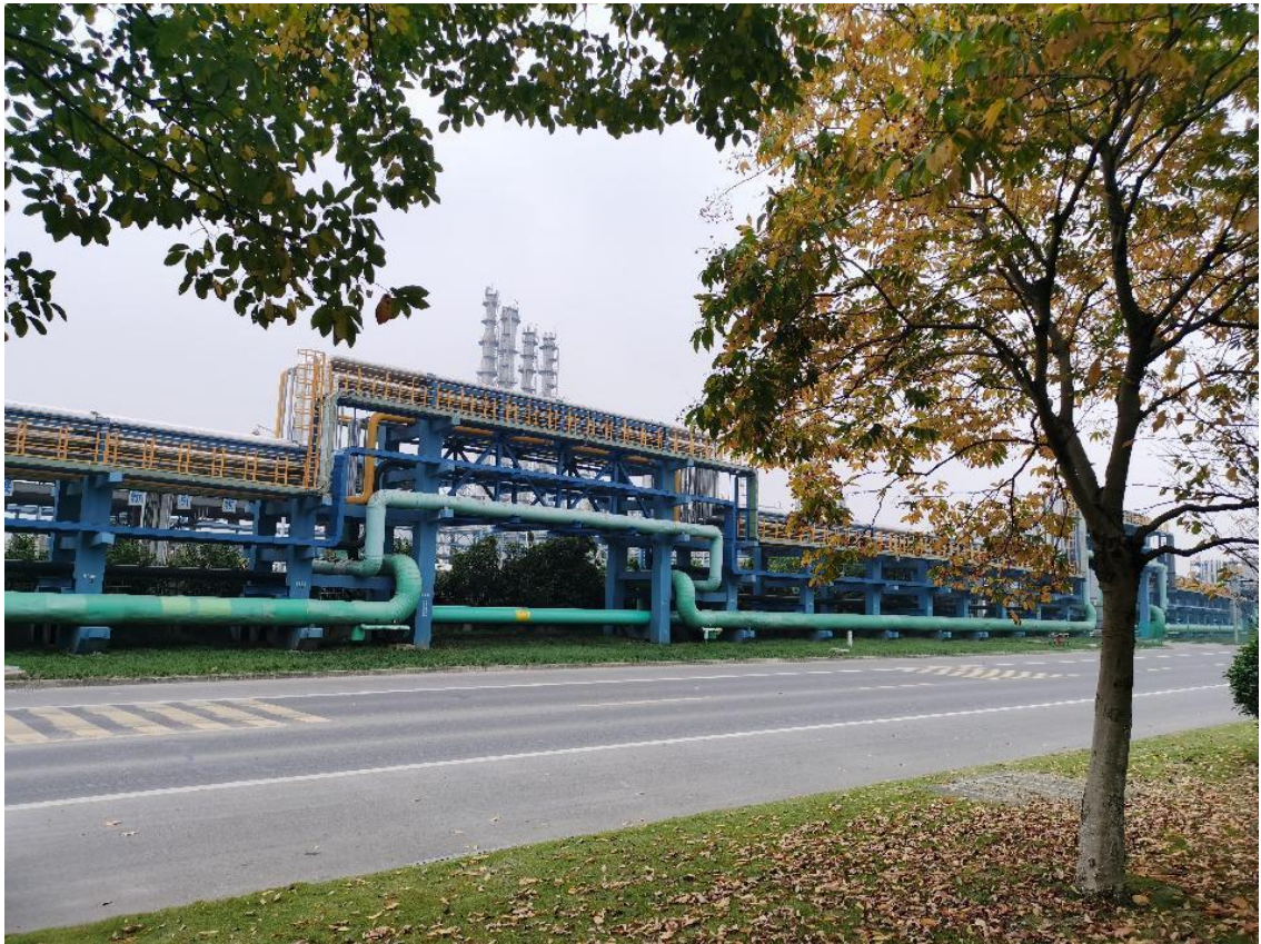
厂区东面园区跃进塘路和园区管廊
