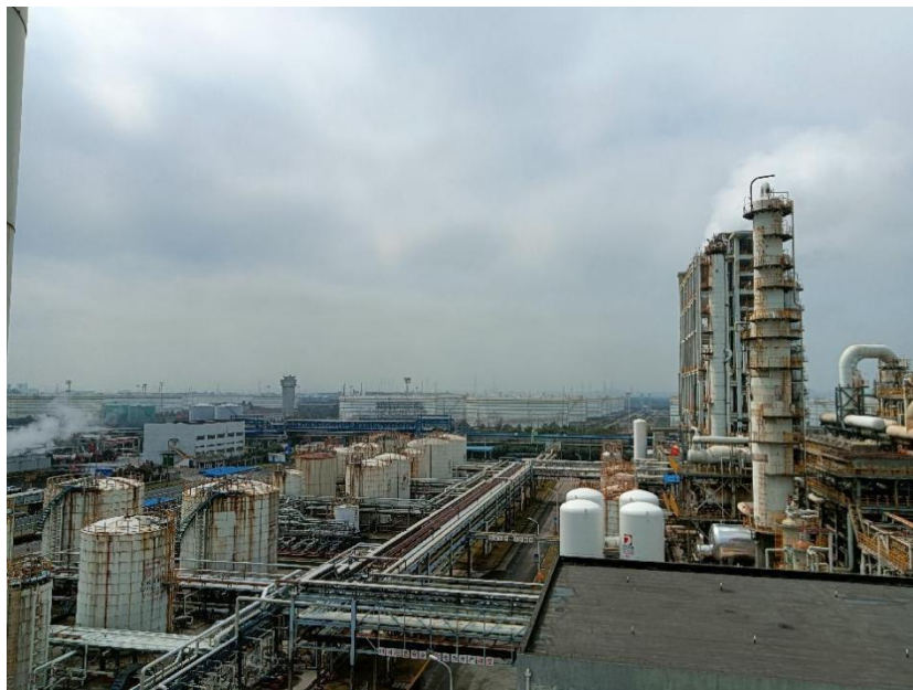
DMC 主装置、原料及产品罐区 2
