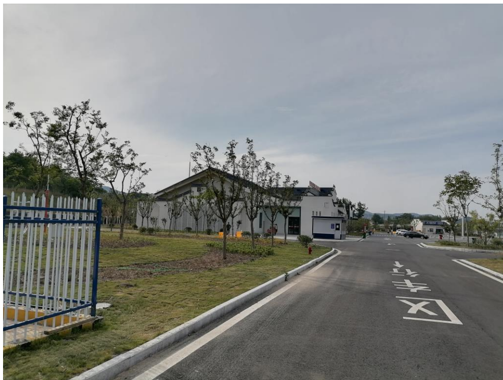
站区西北侧服务区综合楼
