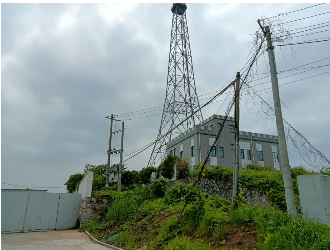
项目北侧信号塔及三层办公楼
